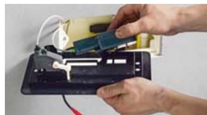
2 Těleso se servomotorem se zastrčí do montážního rámu a namontuje se manuální ovládání, aby se v případě poruchy mohlo splachovat.
