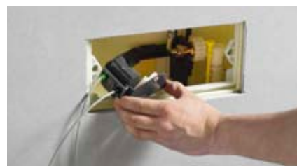
1 Mechanika se vymění za bovdenovou jednotku se servomotorem.
