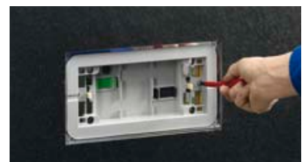
4 Základní deska se připevňuje ke splachovací nádrži, nakonec se namontuje ovládací deska.
