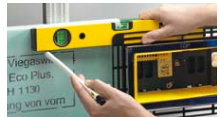
1 Výřez rámu k zabudování se přenese na sádkartonovou desku a vyřízne se nožovou pilkou.
