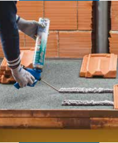
Lepenie strešnej krytiny na pásy
