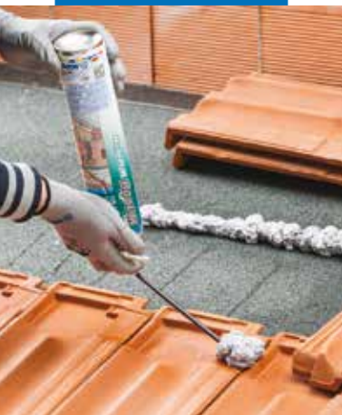
Lepenie strešnej krytiny na pásy
