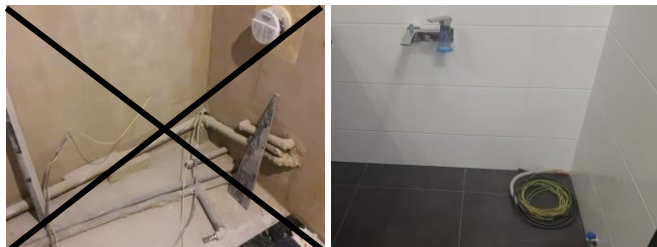
Ilustrační foto - příprava prostoru pod vanu NE ANO
