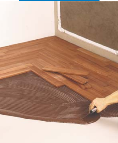
Roztírání lepicího tmelu zubovou stěrkou určenou pro dřevo
