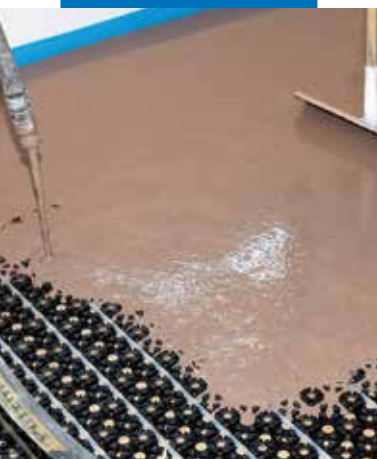
Čerpání a vyrovnání povrchu Novoplan Maxi
