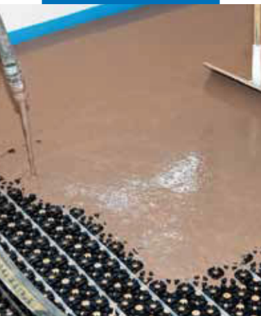
Čerpanie a vyhladenie zmesi Novoplan Maxi
