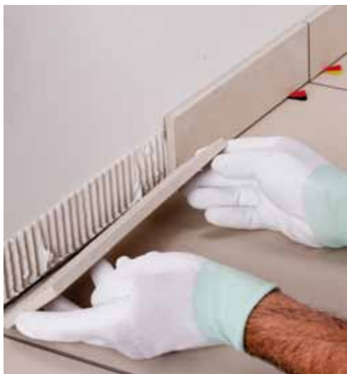
Po obvodu místnosti instalujte soklík tak, aby nedošlo k přímému kontaktu s podlahou
