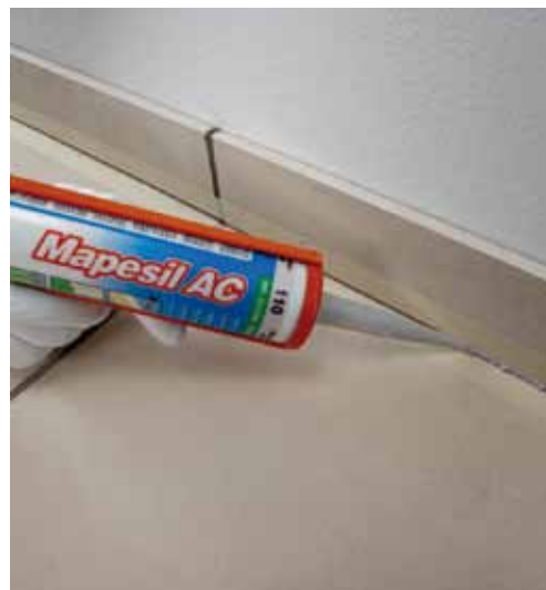
Vhodným pružným těsnicím tmelem vyplňte prostor mezi soklíkem a podlahou
