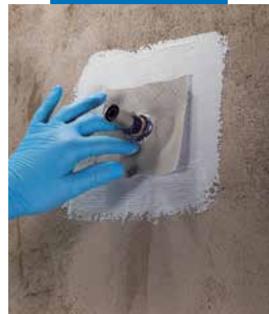
Instalace manžety Mapeband PE 120 na utěsnění prostupu potrubí s použitím Mapegum WPS
