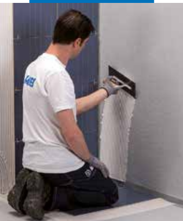
Lepení obkladů s použitím lepidla Keraflex Maxi S1
