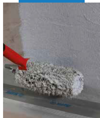
Inštalácia veľkoformátovej dlažby
