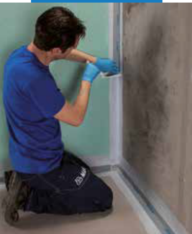
Inštalácia veľkoformátovej dlažby
