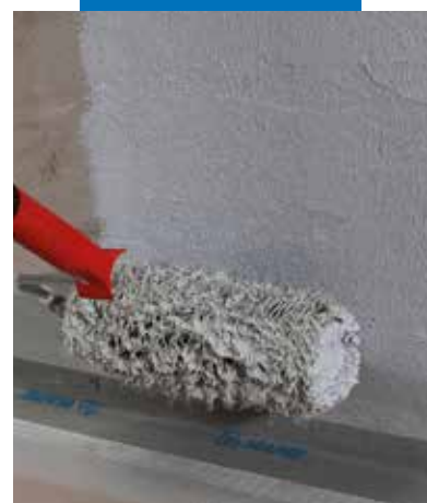
Nanášení hydroizolační stěrky Mapegum WPS válečkem
