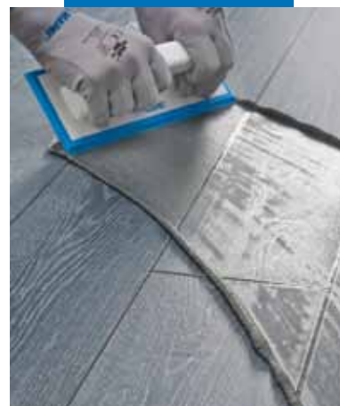
Nanášení Ultracoloru Plus gumovou stěrkou na dlažbu typu gres s efektem dřeva
