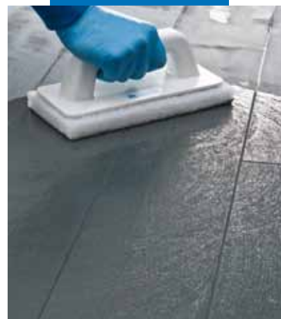
Čištění a konečná úprava spár s použitím Scotch-Brite® (částečně ztužený výrobek)
