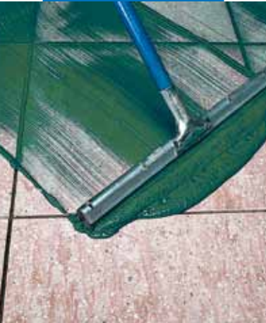
Nanášení Ultracoloru Plus na dlažbu gumovou spárovací stěrkou
