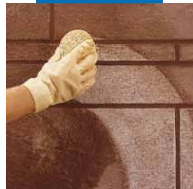
Čištění a konečná úprava spár houbou
