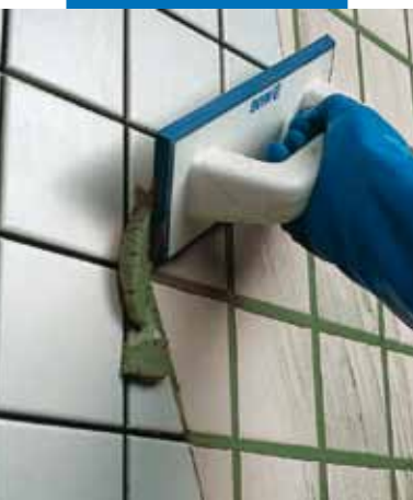
Nanášení Ultracoloru Plus gumovou stěrkou na obklad
