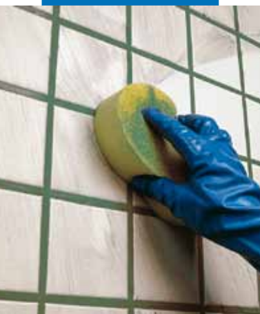
Čištění a konečná úprava obkladů houbou
