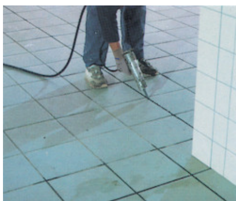
Strojní výplň spár Mapesilem AC v keramické dlažbě
