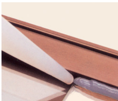
Těsnění hliníkového okenního rámu s použitím Mapesilu AC
