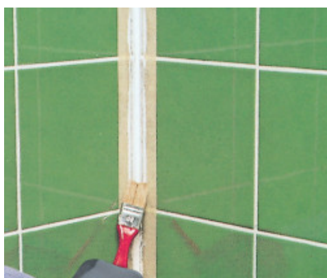
Vyhlázení povrchu spáry saponátovým roztokem a štětcem
