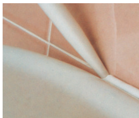
Utěsnění sanitárních předmětů
