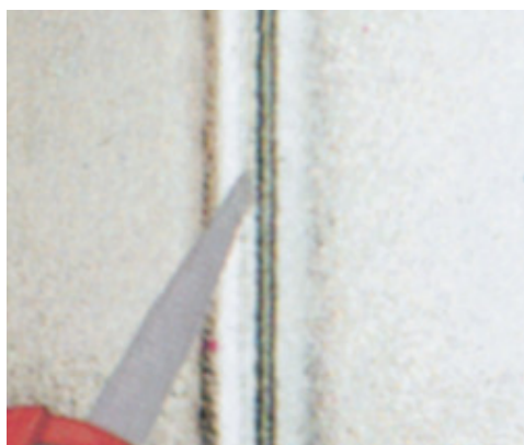
Těsnění skleněných „U“ profilů
