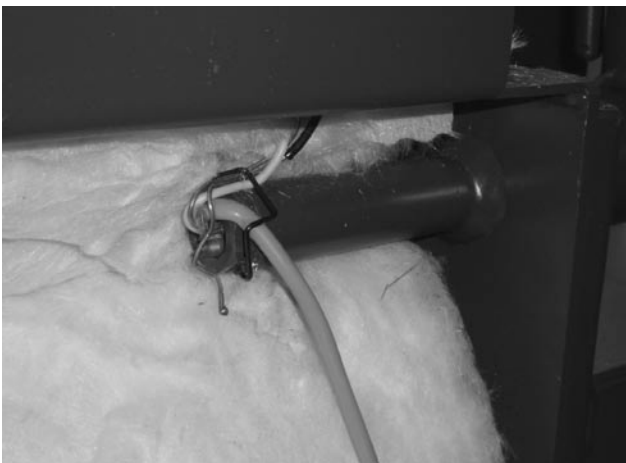
Obr. 15 - pohled na čidlo teploty vody TK v jímce kotle DCxxSP(EP) nebo kotle s hořákem ve vrchních dvířkách DCxxS(X), CxxS, ACxxS, DCxxRS
