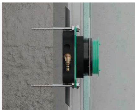
Instalace před stěnu
