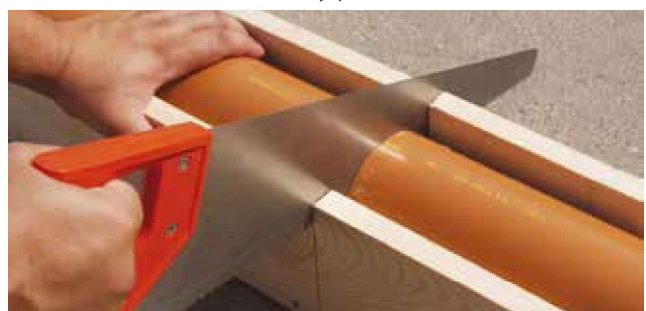
Obrázek 2 Zkracování trubky pilkou
