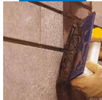
Nanášení Ultracoloru Plus gumovou stěrkou na stěnu
