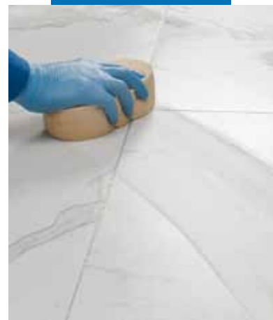
Čištění a konečná úprava spár tvrdou houbou z celulózy
