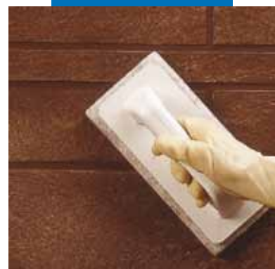
Čištění spár s Scotch-Brite® (částečně ztuhlý výrobek)
