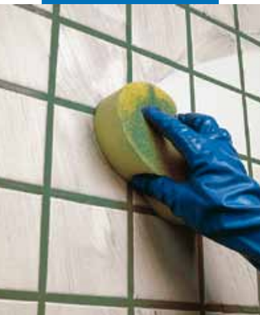
Čištění a konečná úprava obkladů houbou
