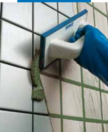
Nanášení Ultracoloru Plus gumovou stěrkou na obklad
