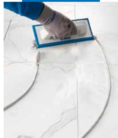
Nanášení Ultracolor Plus gumovou stěrkou na dlažbu typu gres s efektem mramoru
