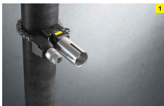
1. Na ocelovou trubku se připevní speciální vrtací pouzdro pro vedení vrtacího vřetena.
