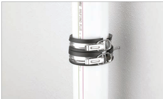
Obr. 9–6 Dokončená instalace podpěrného upevnění
