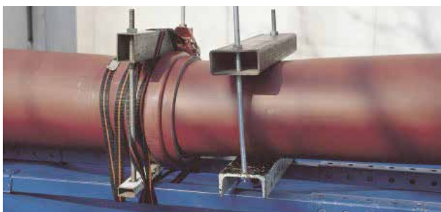
Zkouška těsnosti spoje (PP MASTER)
