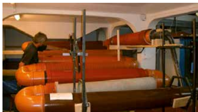
Sestava trub na VUT Brno
