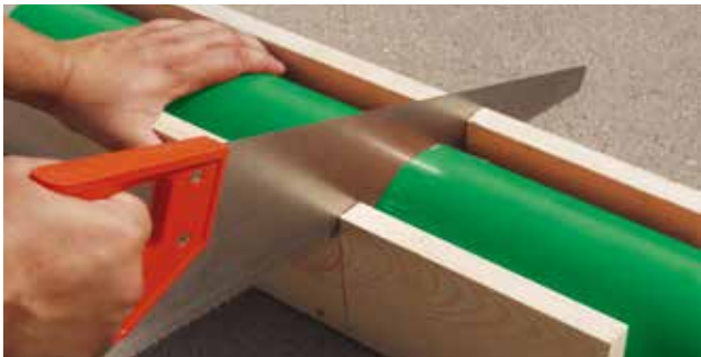
Obrázek 6 Zkracování trubky pilkou
