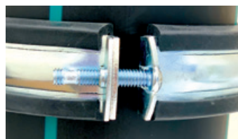
Způsob utažení dolní pevné objímky
