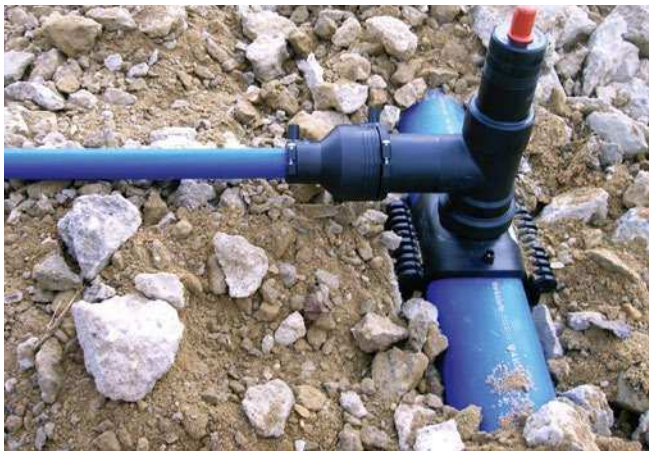
Porovnání svařování elektrotvarovkami a metodou na tupo
