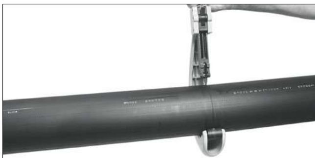
Řez potrubí ruční rotační rezačkou
