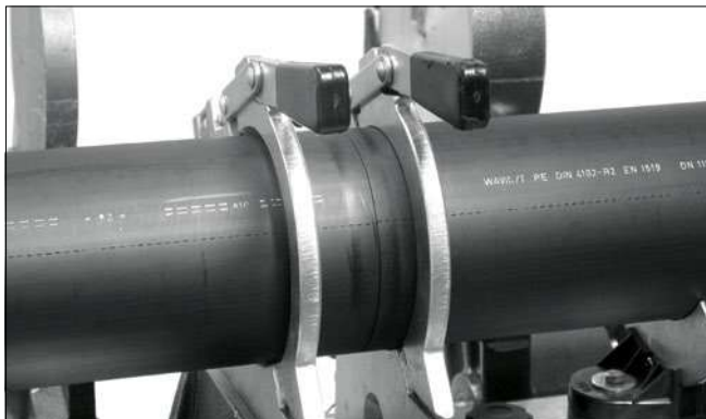
Správně připravené potrubí ke svařování
