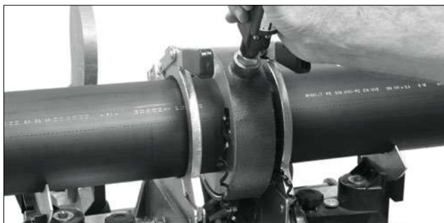
Srovnání konců potrubí integrovaným hoblíkem
