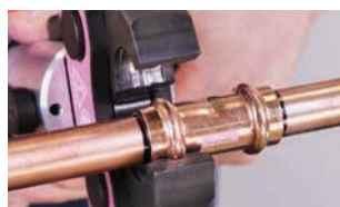
11. Nasadte lisovací čelist pod pravým úhlem
