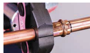
12. Provedte zalisování
