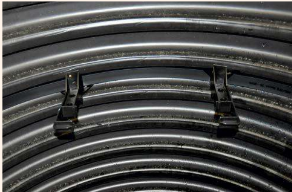
Předpříprava obruče žebříku v šachtové trubce
