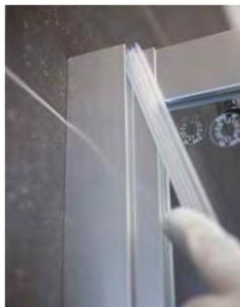
Snadná montáž díky HÜPPE technice upevnění s použitím těsnícího profilu - bezpečná, velice snadná montáž osvědčeným způsobem - žádné šrouby v prostoru nástěnné lišty
