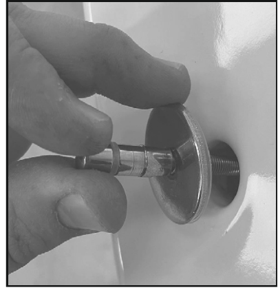
03 Avvitare il fissaggio tenendolo sollevato ma non bloccare. Tighten the fixing screw by keeping it lifted do not block it.
