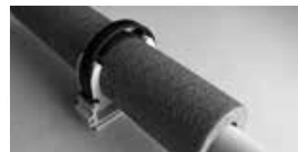
... vedením potrubí v izolaci pod omítkou
