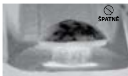
ŠPATNÝ ZÁBĚR ŠROUBU (OVÁLNÝ KRK KAŽDÉHO ŠROUBU NESEDÍ SPRÁVNĚ V OTVORU PRO ŠROUB)
