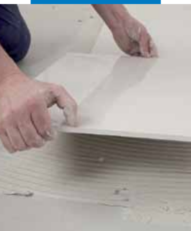
Pokládka keramické dlažby
