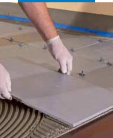
Pokládka keramické dlažby
