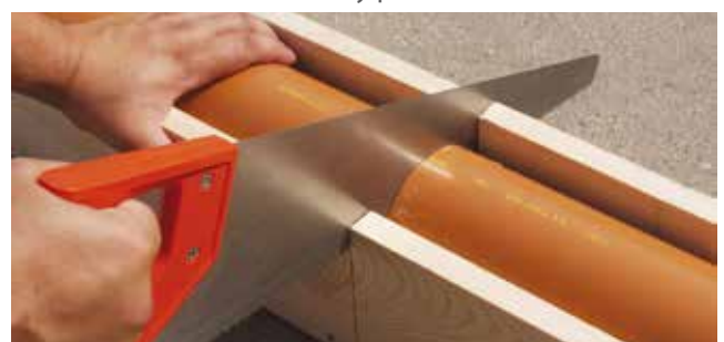
Obrázek 2 Zkracování trubky pilkou
