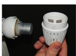
**3b)** Chcete-li zablokovat rozsah nastavení, umístěte omezovač vpravo od čísla odpovídajícího maximální požadované cloně a omezovač vlevo od čísla odpovídající minimální požadované cloně. To brání tomu, aby se hlava budě otevřela nebo zavřela.
