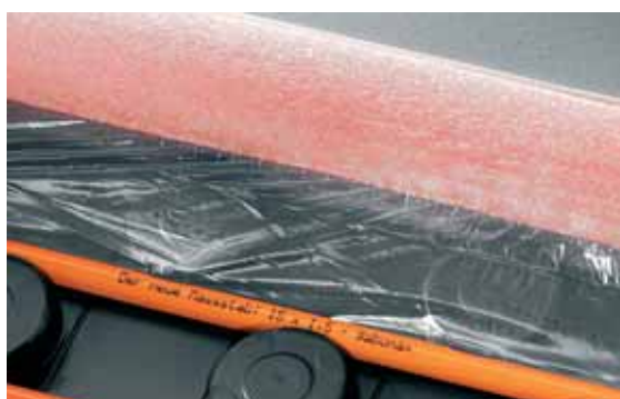
5d. Přichycení fólie dilatačního pásu (pouze u tekutého potěru)
