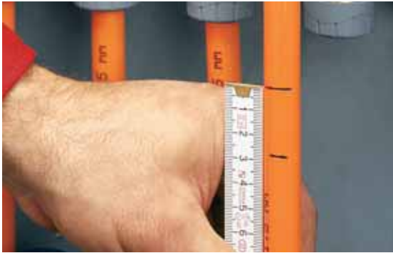
6a. Označení hloubky zasunutí 27 mm
