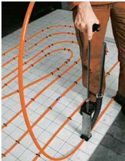
2. Po položení systémových pásů ukládání trubky do spirály
