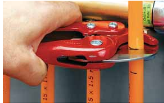
6b. Úprava délky trubky na horní značce
