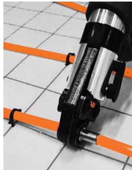
3. Spojení trubek lisovacím spojem
