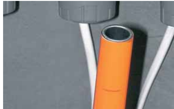
6d. Kontrola usazení opěrného pouzdra
