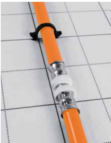
4. Detail uložení trubek na systémovém pásu
