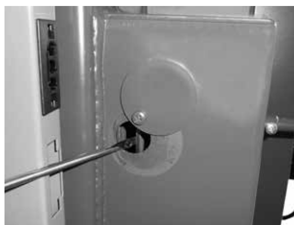
Kontrola a čištění regulace poměru primárního a sekundárního vzduchu čistícím otvorem
