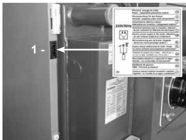
Konektor v pravé kapotě kotle
