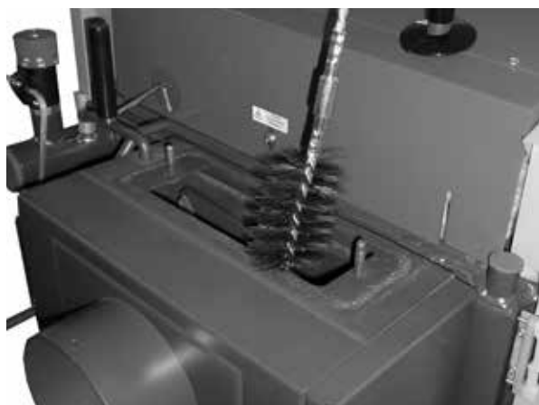
Ukázka čištění kouřového kanálu drátěným kartáčem - vrchní víčko
