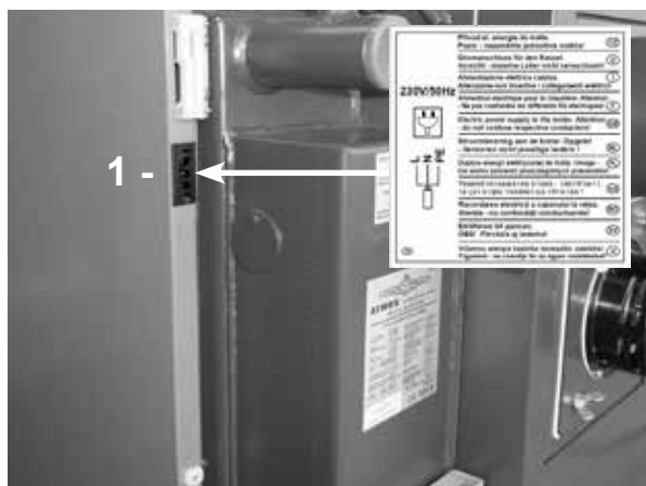
Konektor v pravé kapotě kotle
